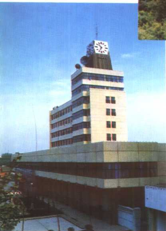
宝鸡市邮电大楼外景
