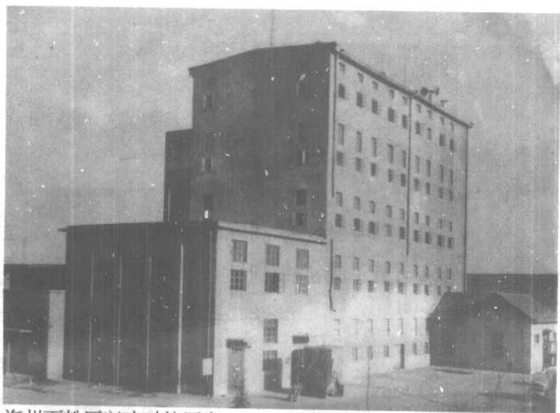
海州面粉厂兴建时的厂房
