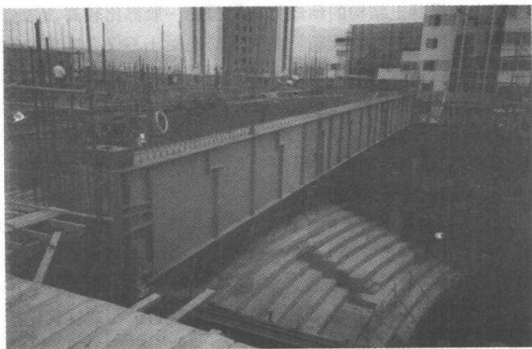
图 1-6 预应力钢—混凝土组合简支梁
