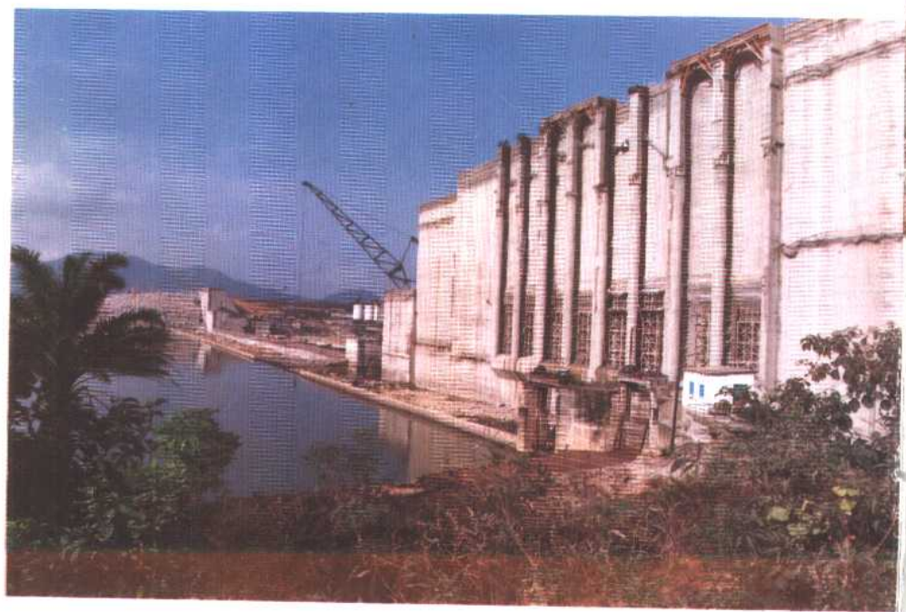
海南大广坝混凝土坝全貌
