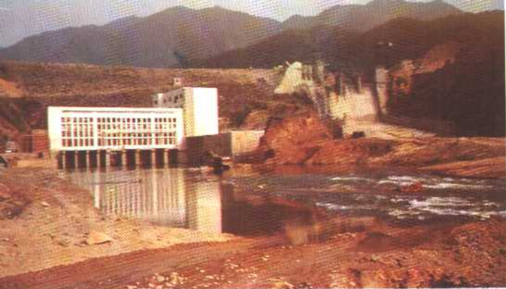
湖南株树桥 工程大坝和厂房
