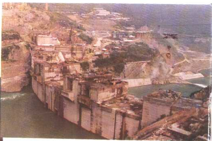
湖北隔河岩水利枢纽大坝正在上升
