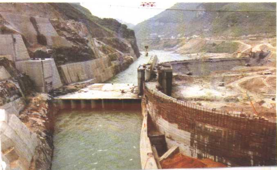
广西岩滩水电站左岸导流明渠
