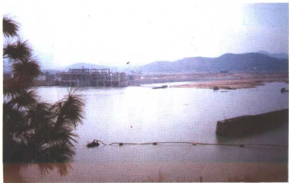
广西蒙山福利水电站上游全景
