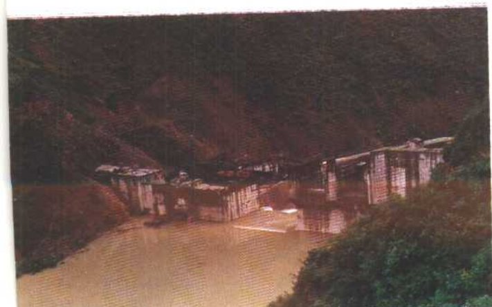
湖北保康马桥 一级水电站大坝施工
