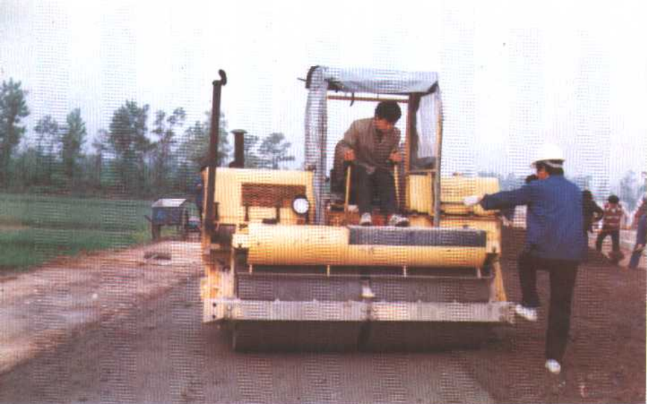
湖北宜黄高速公路路面RCC浇筑
