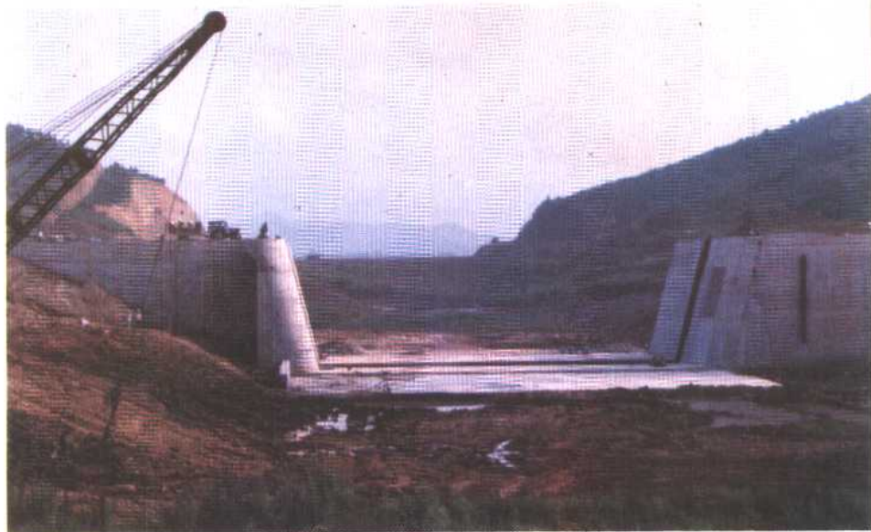
江西瑞昌江洲船闸上闸首及东翼墙
