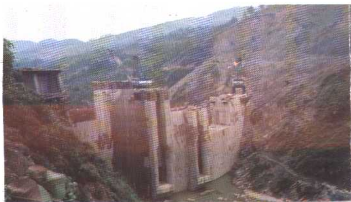
湖北宣恩龙洞水电站对 数螺旋双曲拱坝在施工中
