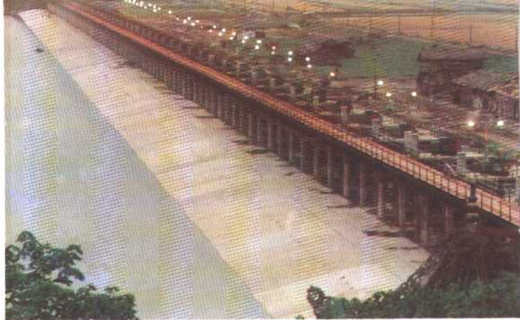
湖北荆江分洪 北闸加高加固工程 晨曦
