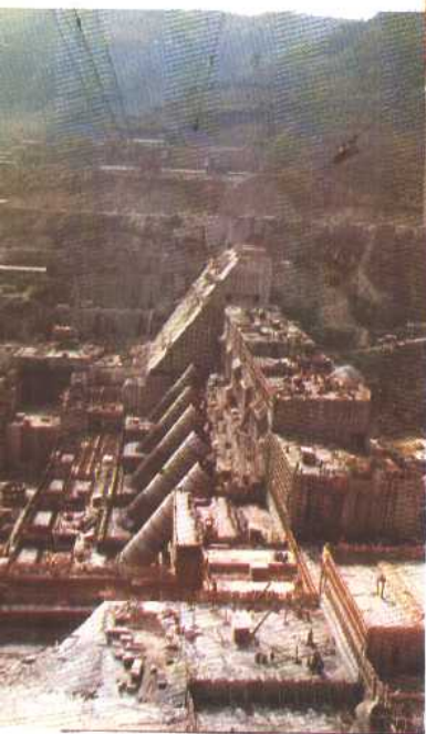
正在施工中的云南漫湾水电站工程
