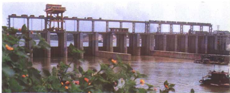
广西桂平航运枢纽泄水闸雄姿
