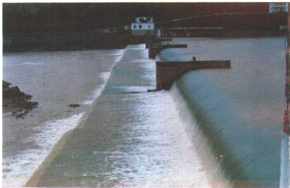
广东龙川枕头寨水电站橡胶坝正在泄洪
