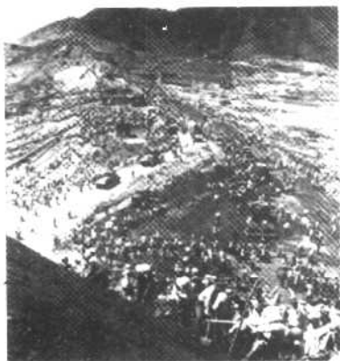
热火朝天的兴修水利工地。
