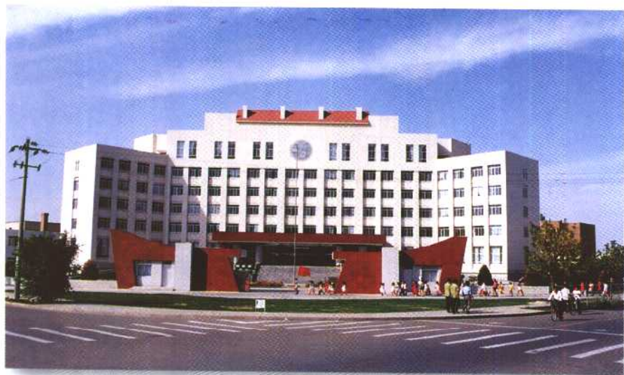
中共金昌市委办公大楼
