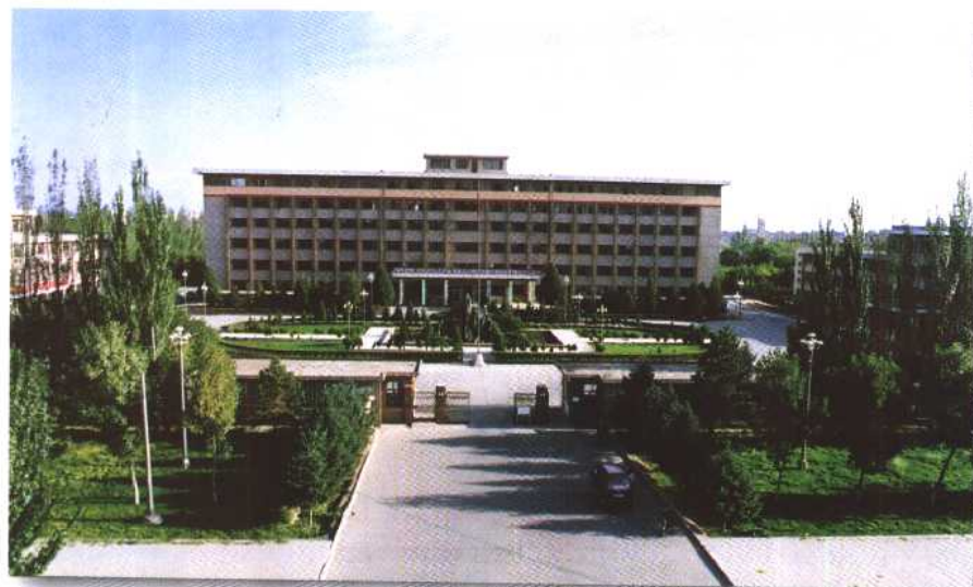
金昌市人民政府办公大楼
