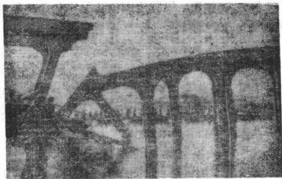
图1-2 比利时Hasselt大桥于1938年3月脆性断裂后的照片
