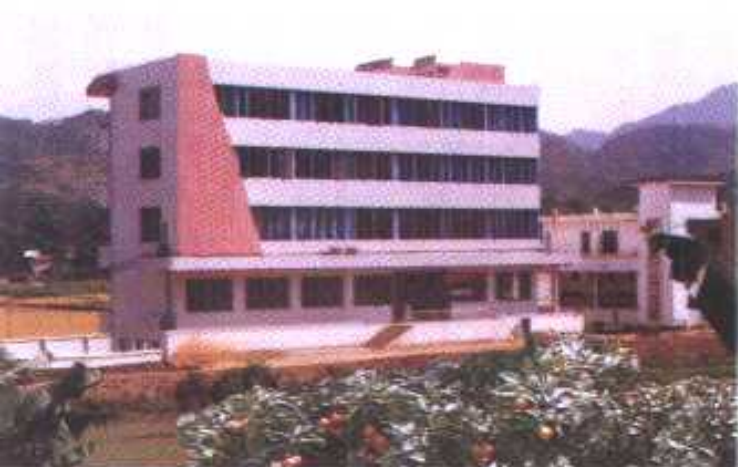
◀ 邮电大楼拔地而起
