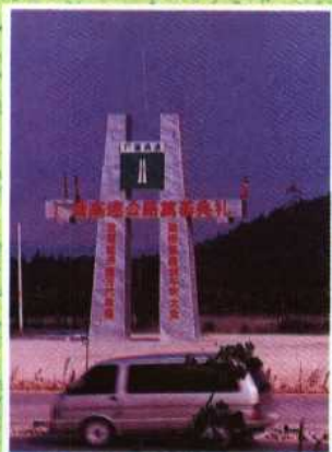
矗立在马安镇内的 广肇高速公路奠基标志
