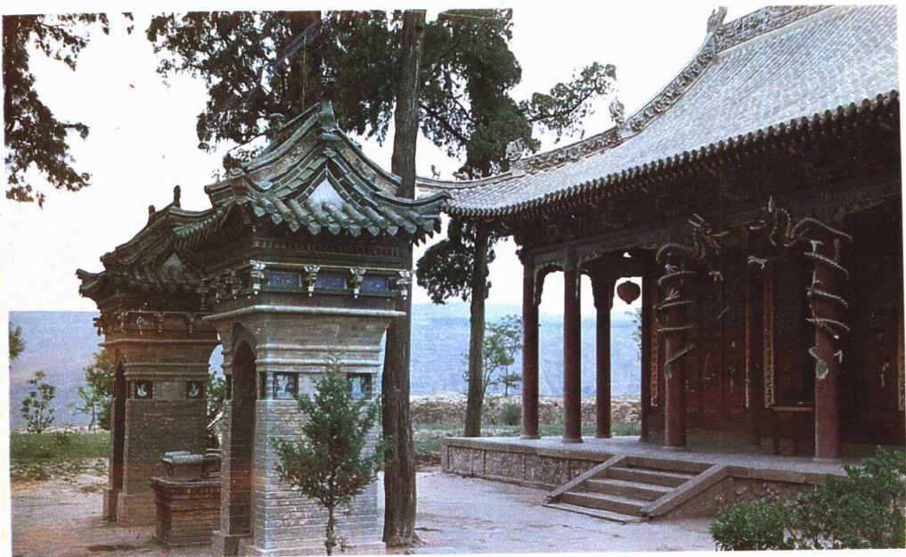
天水三阳川卦台山伏羲庙
