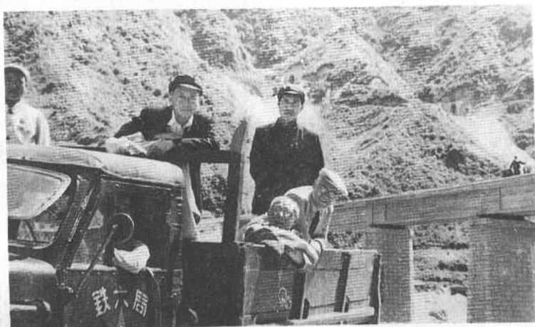
视察修建中的宝成铁路(1956年)
