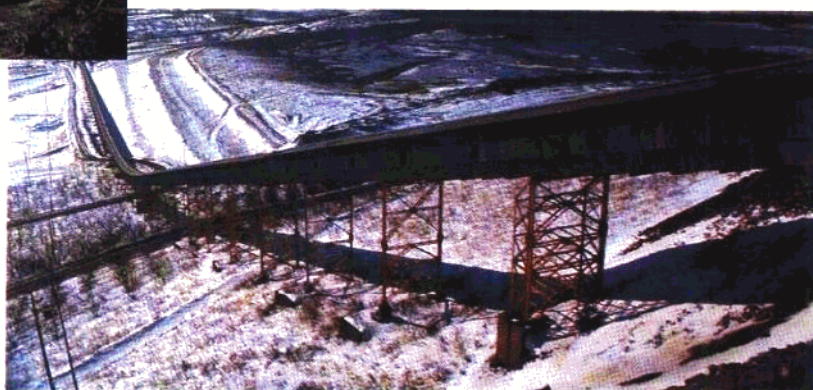
• 鞍钢矿山公司自行设计的高强度皮带运输机通廊
