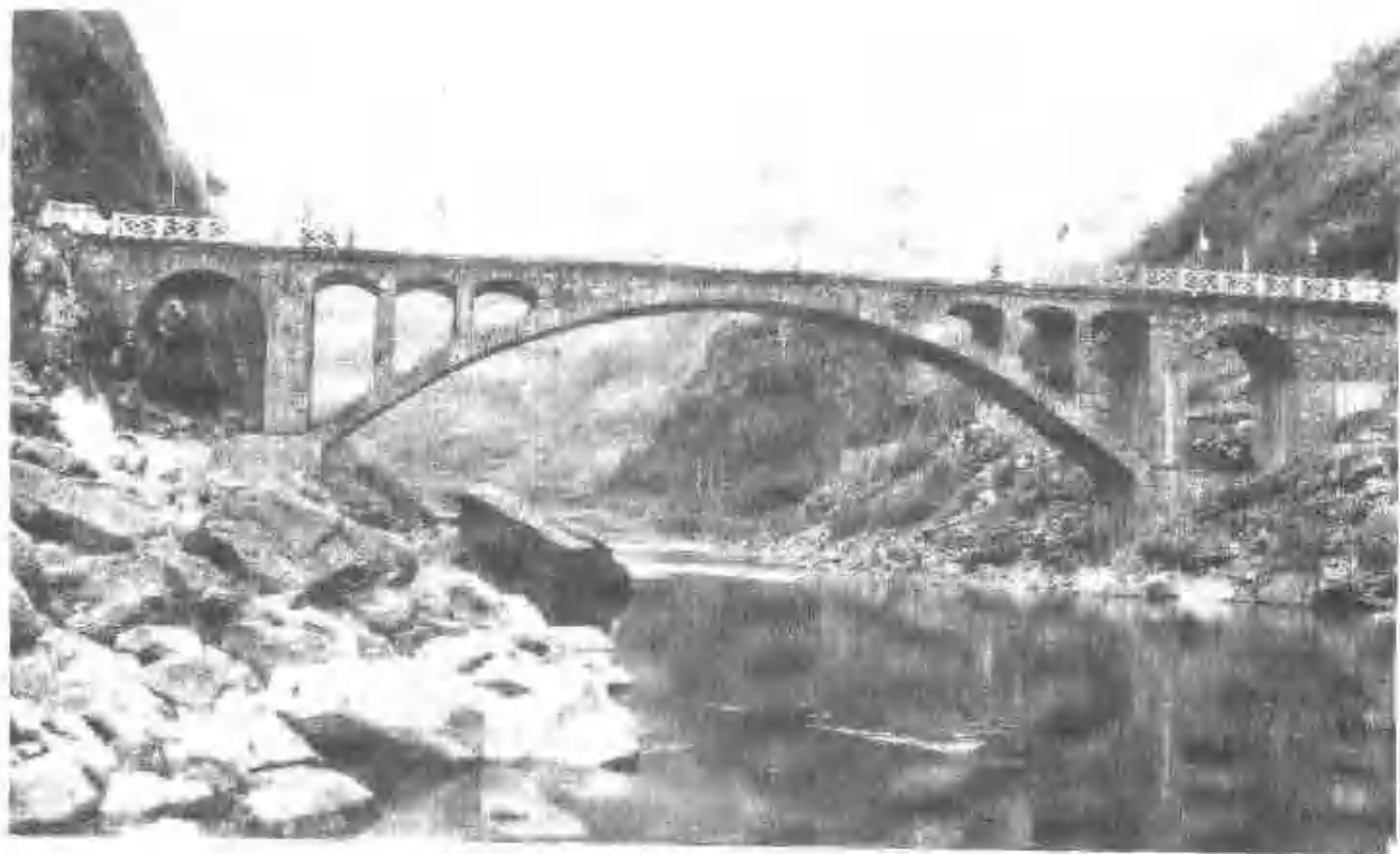
用民族经费修建的罗甸县八茂大桥
