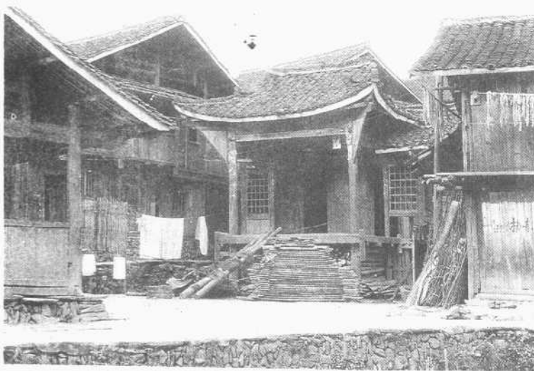
图 1-11 戏台，通道，阳朔 戏台对面是厅堂式鼓楼。注意左后方山墙面梁架构造
