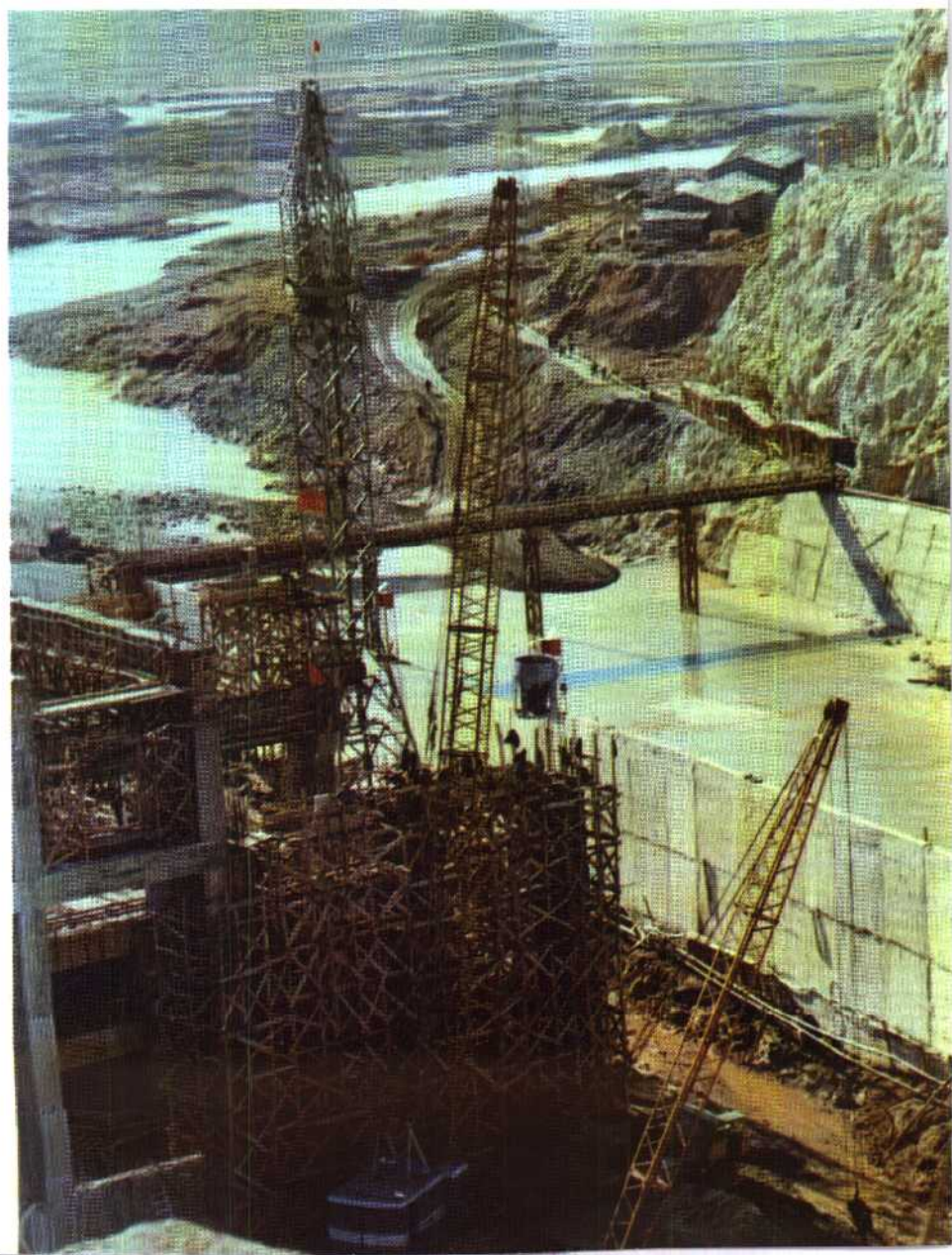
宏伟的毛泽东水电站建设工地。
