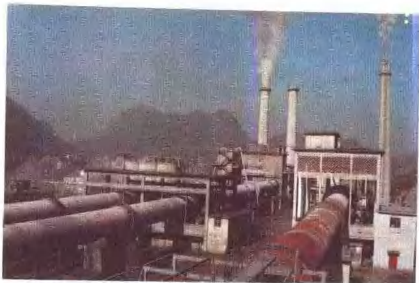
▲水城水泥厂年产30万吨的第三条水泥生产线
