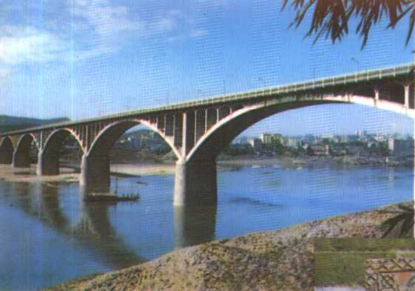
▲ 渠县渠江公路大桥
