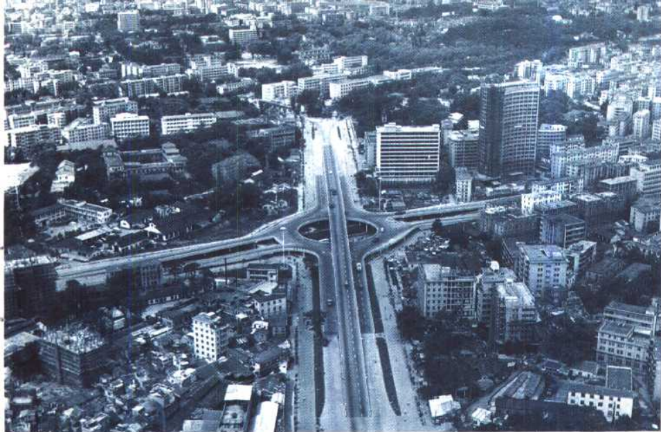
新建的区庄立体交叉桥
