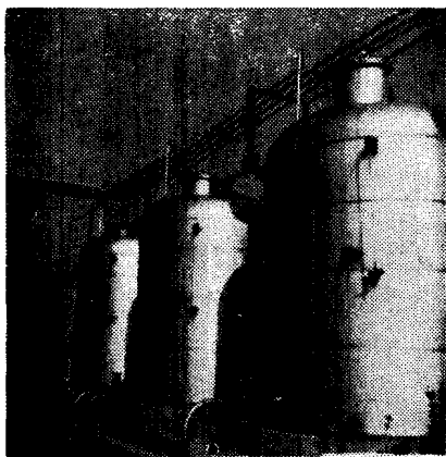
图 5 \phi 1030 \times 15 毫米 \text{SO}_2 塑料管路
