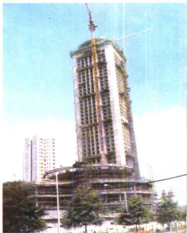
建设中的国贸大厦
