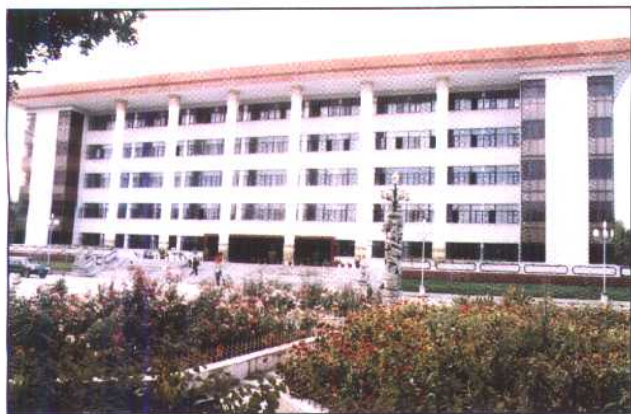
州党委办公大楼
