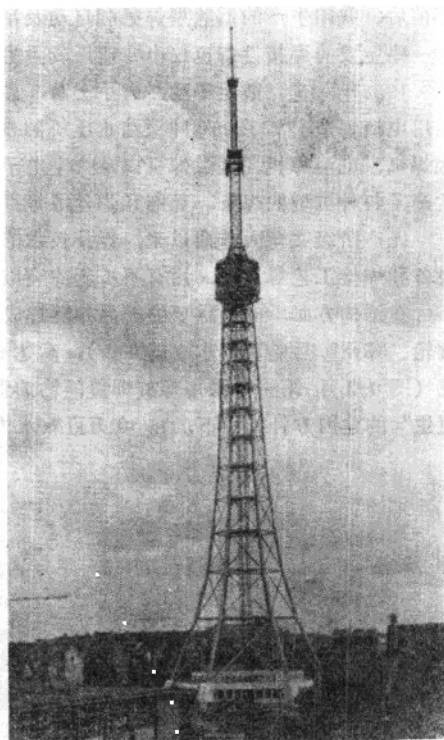
图0-4 209米全焊接结构电视塔
