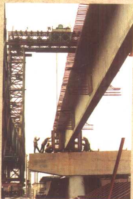
工人们正在吊装大桥引桥第一片 30M 大梁。
