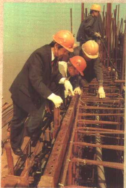
大桥监理工程师在施工现场对工程质量进行严格把关。
