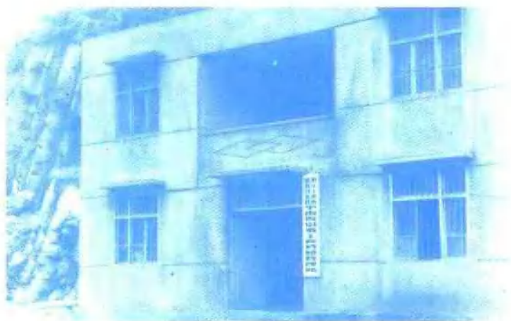
位于斜桥的渠道管理站。(王绍明摄)
