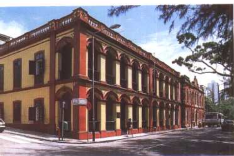
座落于荷兰园正街富有欧陆特色的古旧建筑
