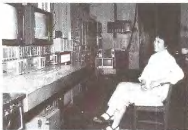
70年代的江西电视台微波机房
