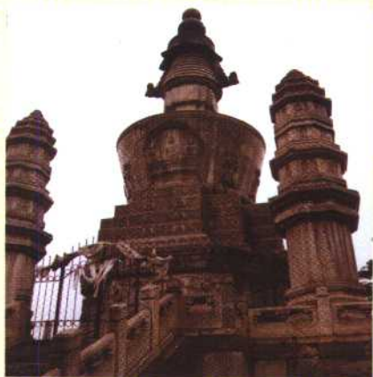
西黄寺清净化城塔
