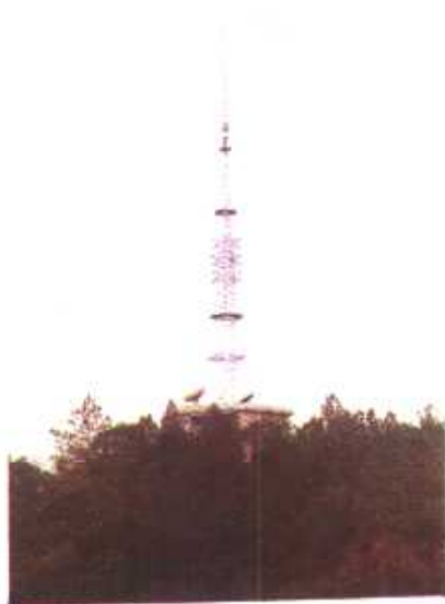
县广播电视中心发射塔
