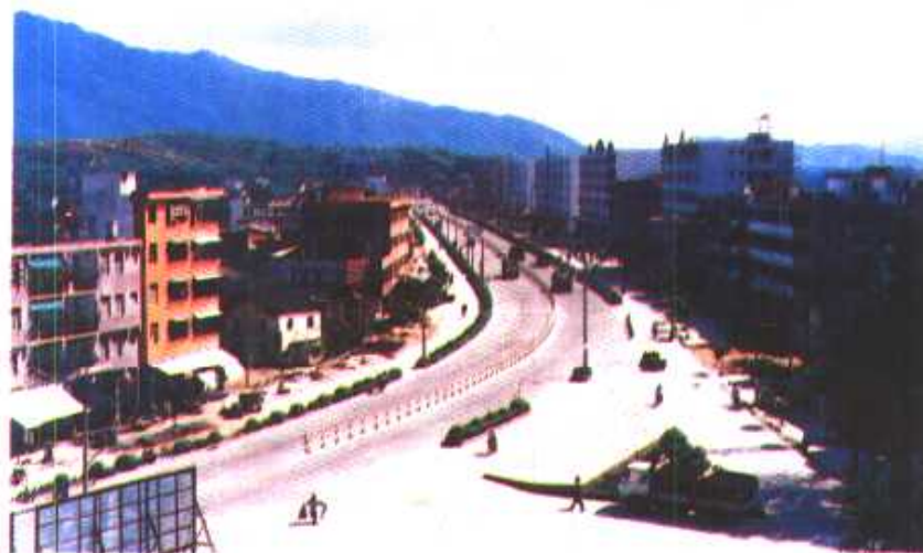
◀ 改造后的 蕉城段新貌 205国道
