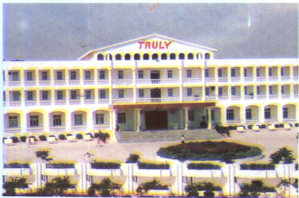
林伟华先生的信利电子工业城办公大楼
