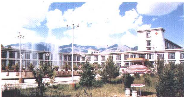
西藏自治区藏医院住院部
