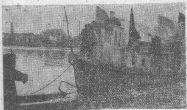
图 3 40匹馬力鋼絲网水泥拖輪
