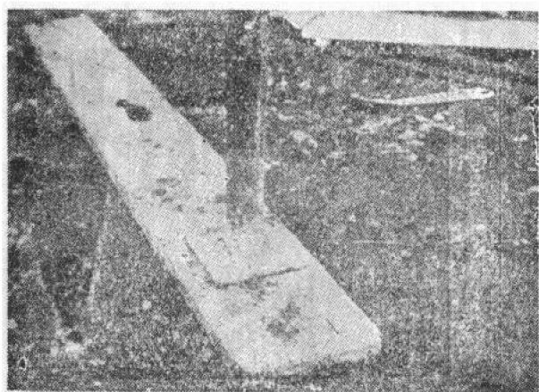
图2 支柱应有坚固的支承 (经水泥和混凝土协会特许转载)
