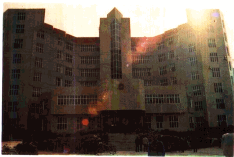
△县政府办公大楼
