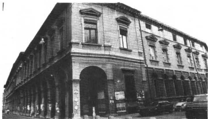
波吉大楼外景
