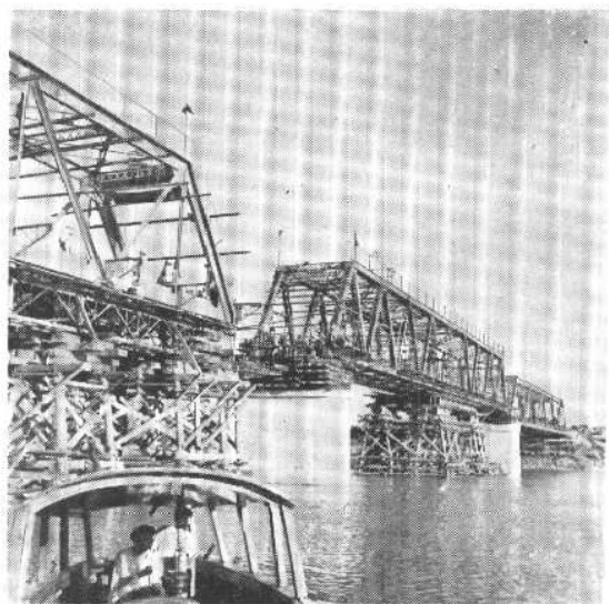
中国援助的全部铁路桥梁系统中的河—荣 綫都連大桥。
