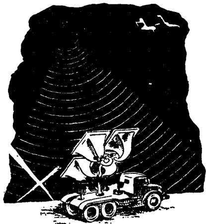
图1 防空听音器在收听到飞机的声音时，飞机已飞过了数公里，存在很大的误差
