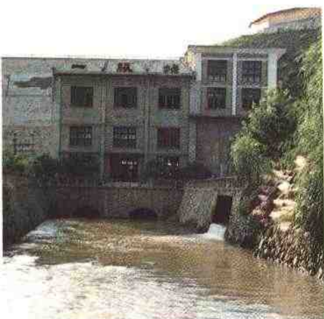
▲青印溪一级水电站
