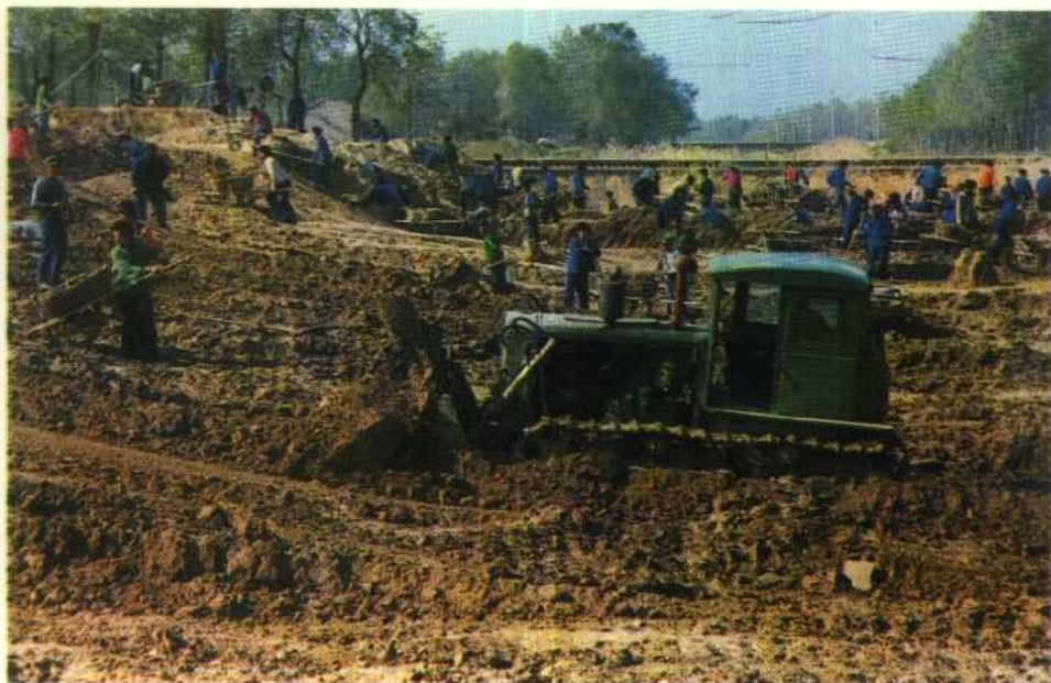
陵县人民大兴农田水利建设，改善农业生产条件，保证农业稳产高产。图为农田水利建设现场。
