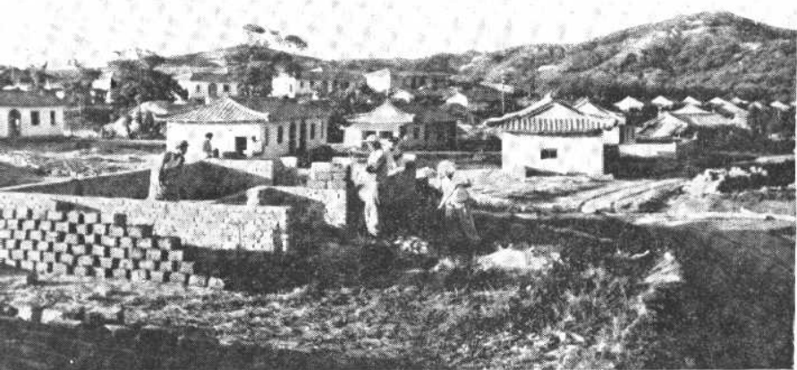
建筑工人正在为农民建设新住宅
