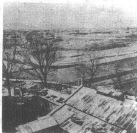
化学品储藏室被破坏情形
