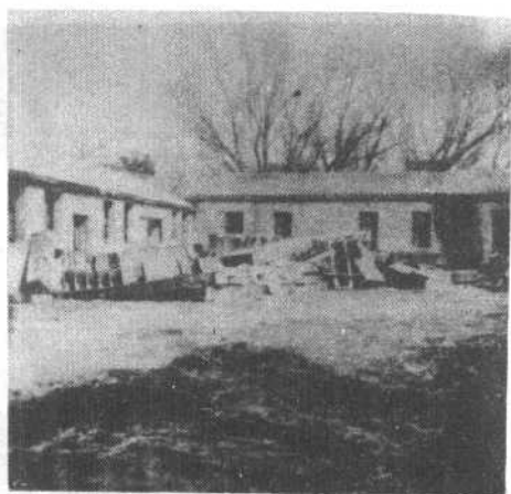
体育馆铁衣架被全部弃之室外任其锈烂
