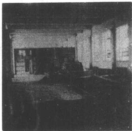
机械工程馆内机器荡然无存
