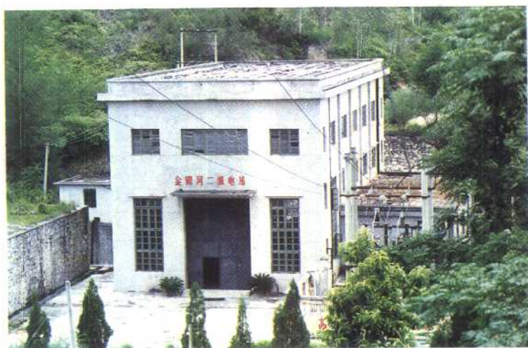
金銀河二级电站 设计水头 30.5m, 装机 2 \times 3000\text{KW} , 设计年发电 1800 万千瓦时。
