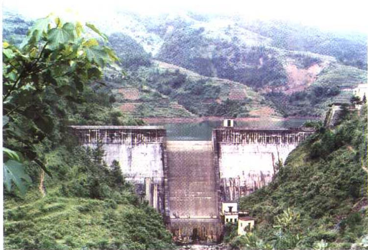
湘洞水库 集雨面积 39.2 平方公里, 总库容 1680 万 \text{m}^3 , 是引泗灌区的一个补偿调节水库。图为水库砼重力坝, 坝顶长 125 米, 最大坝高 44 米。
