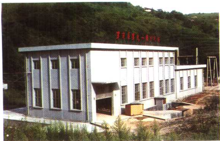
罗光一级电站 总装机容量 2 \times 630 千瓦, 设计年发电 260 万千瓦时。
