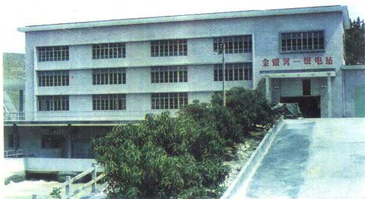
金銀河一级电站 设计水头 21m, 装机容量 4 \times 1250\text{KW} , 设计年发电 1713.7 万千瓦时。
