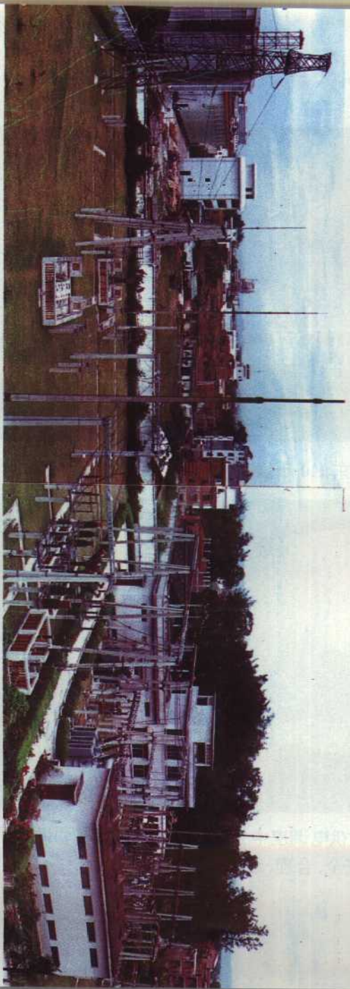
罗城城西输变电站 以 35 千伏和 110 千伏两个等级进行输变电, 35 千伏等级变电容量 1.0 万千伏安, 110 千伏等级变电容量 2.0 万千伏安。
