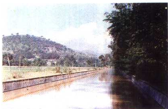
改造后的引泗引水干渠。
