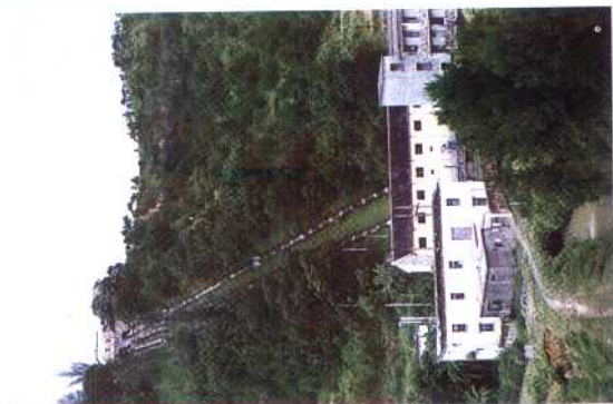
山垌二级电站 设计 水头 72m, 装机 3 \times 500 千瓦, 设计年发电量 420 万千瓦时。
