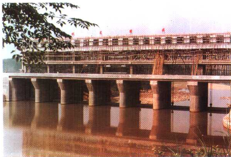
双东水电站 拦河闸坝。
