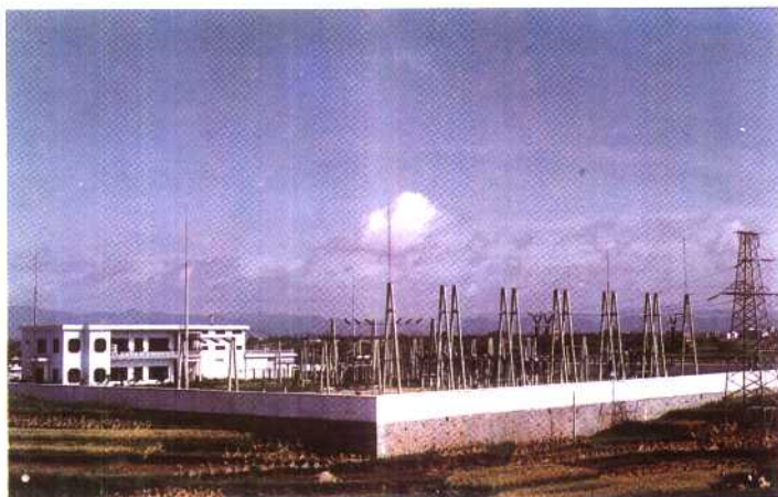
罗城城东 110 千伏输变电站 变电容量 3.15 万千伏安。
