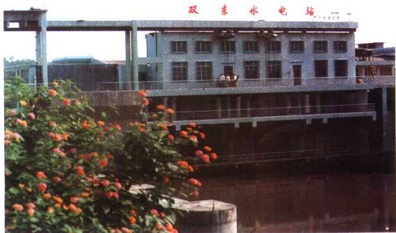
双东水电站 总装机 3 \times 2000 千瓦，设计年发电量 2150 万千瓦时。
