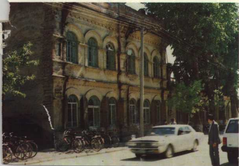
归侨张德馨出资建的楼房。曾是抗日 将领马占山的故居之一。（洪流摄）
