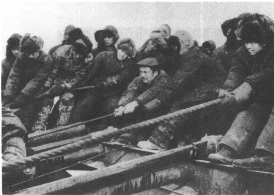
铁人带领广大石油工人，以大无畏的英雄气概，人拉肩扛，把六十多吨的钻机运到井场。这是铁人和工人正在安装钻机。
