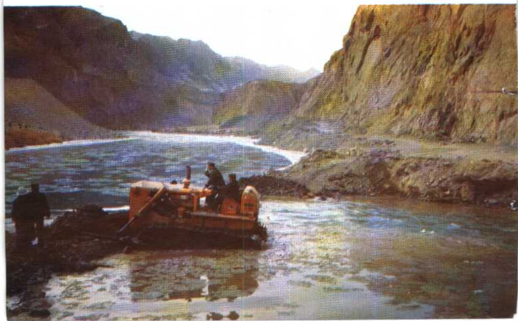
正在施工的大山口水电站
