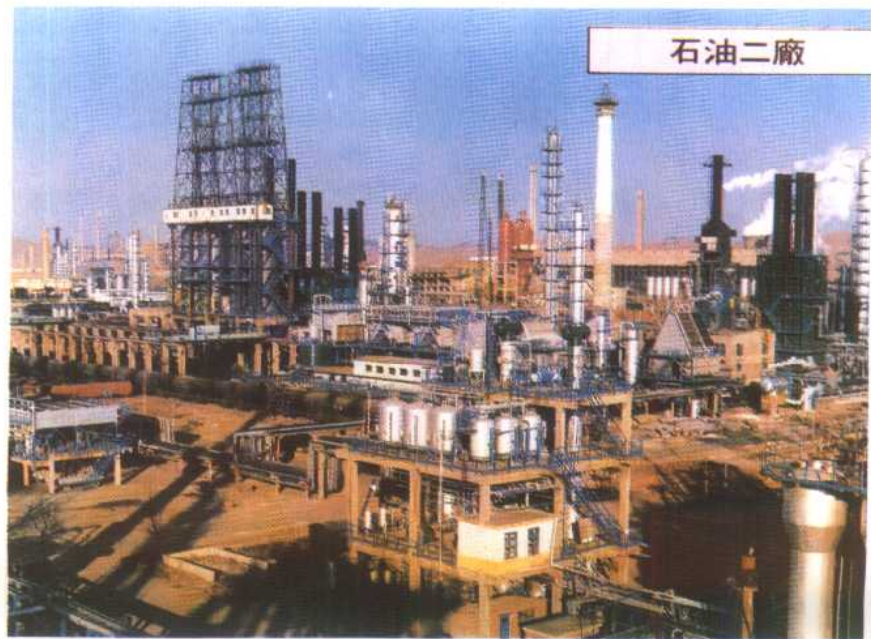
大型石油化工企业: 抚顺石油二厂
