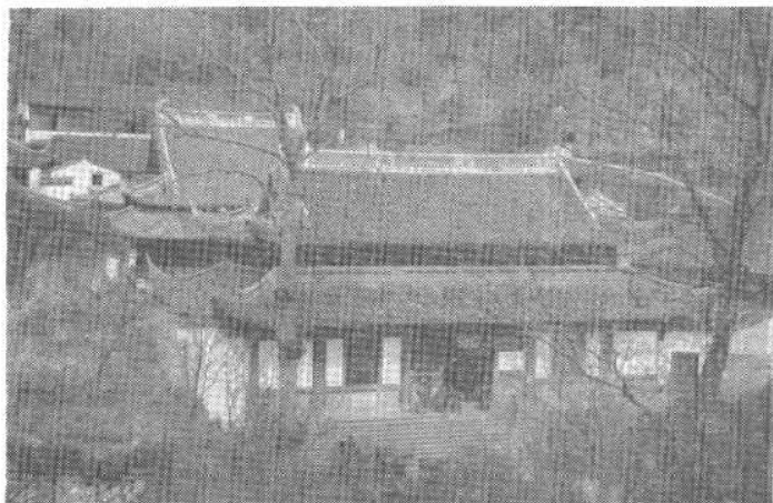
保国寺全景——北宋木结构建筑
