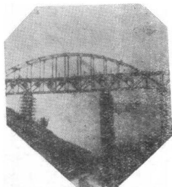
图 1-4 用普低钢制造的大跨度栓焊梁
