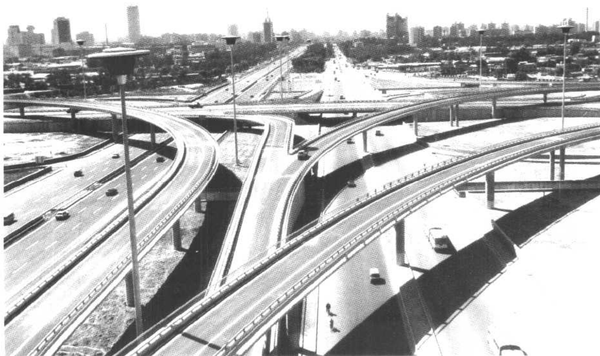
图为北京四元立交桥全景。
