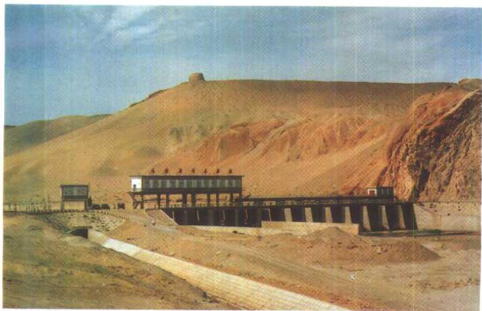
金塔大墩门引水枢纽
