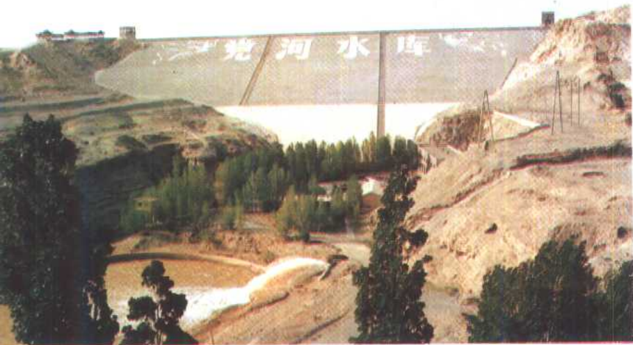
两西建设前十年扩建加固的敦煌党河水库
