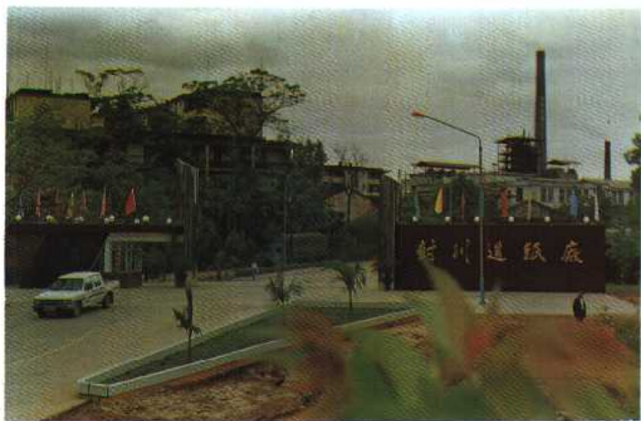
◇ 位于 321 国道旁的封川 造纸厂新大门
